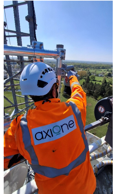
Installation sur un pylône télécom
