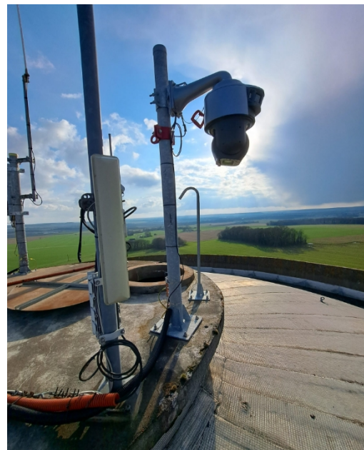
Installation sur un château d'eau
